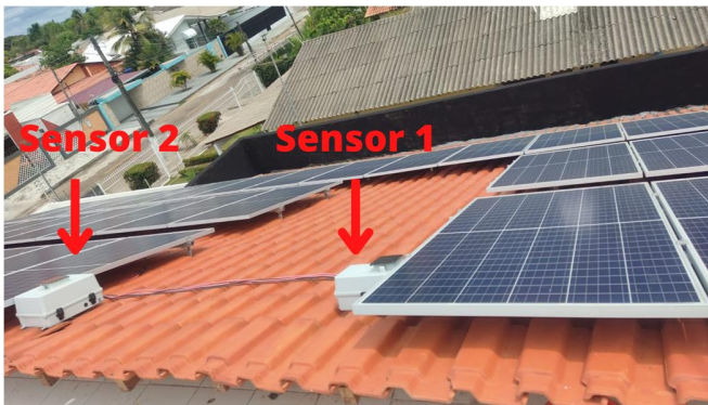
Figura 9 - Localização dos sensores em relação aos painéis da microgeração.
